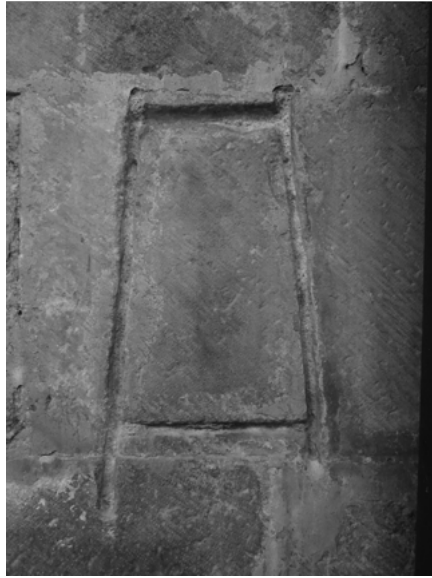
Figure 2 – Gabarit de tuile trapézoïdale, mur sud de la nef de l'église Notre-Dame-des-Paneaux à Cluny. Le plus petit côté (en haut) mesure environ 20 cm. (Source : photographie personnelle)
