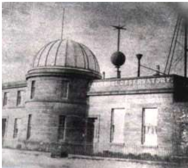
Figure 8-2 - Time-ball installé sur le premier observatoire naval du Waterloo Dock de Liverpool en 1845
